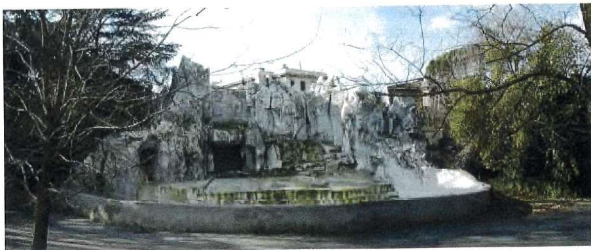
VISTA FRONTALE ANTE OPERAM
