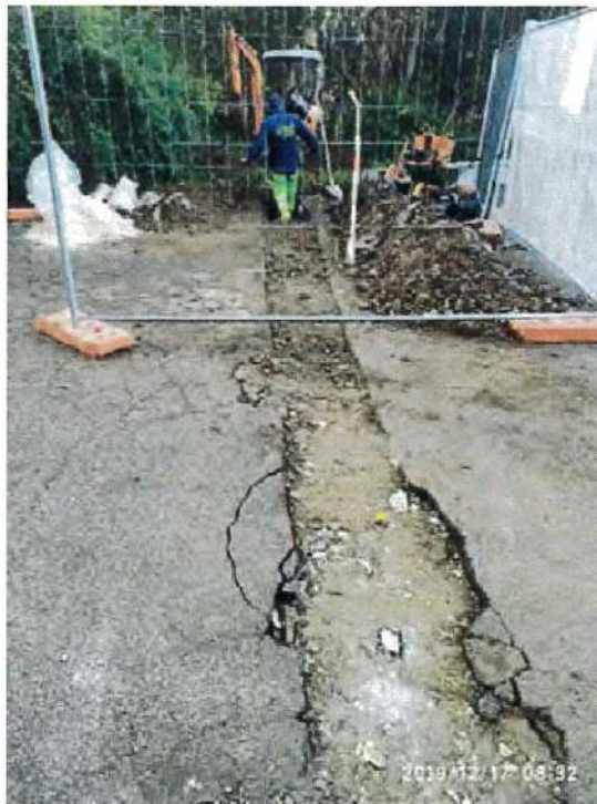
6) Opere fognarie per collegamento pozzetto cancello ingresso fornitori.
